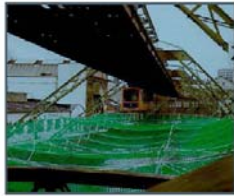
Esempio di utilizzo di un sistema S (costruzione di ponti e cavalcavia)
