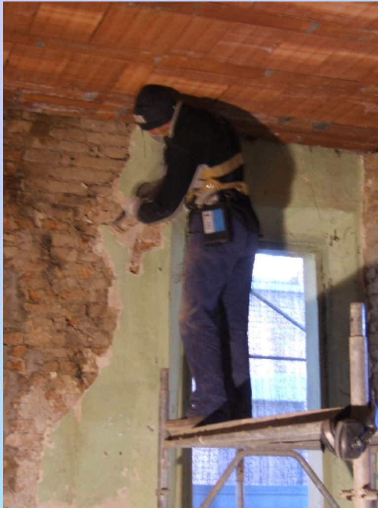
Demolizione manuale intonaco
