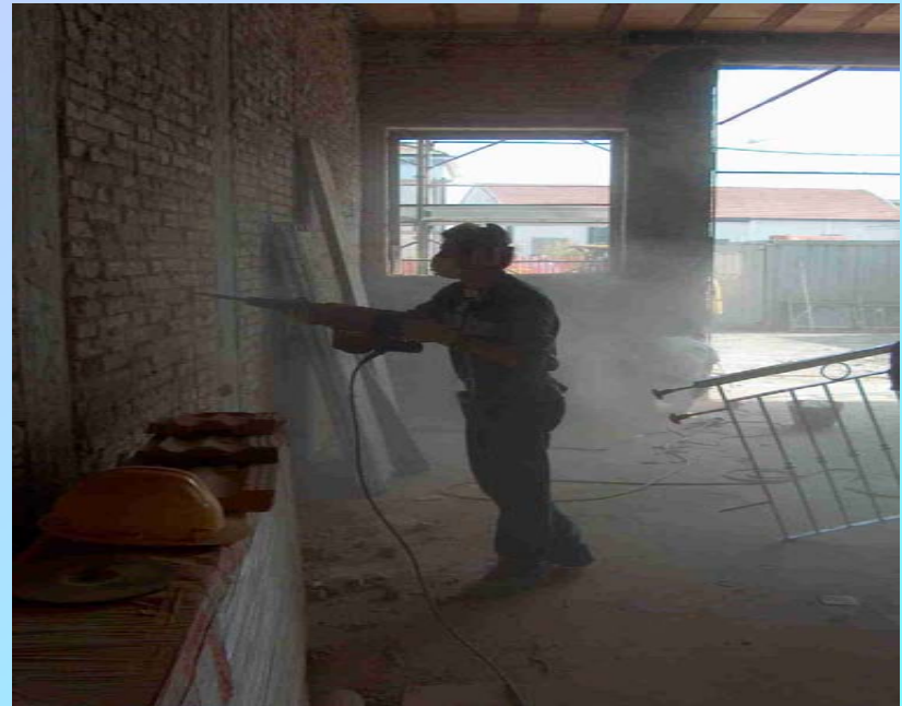
Svuotamento traccia su mattoni pieni con martello percussore
