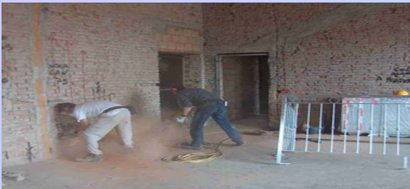
Esecuzione taglio e svuotamento traccia su mattoni pieni
