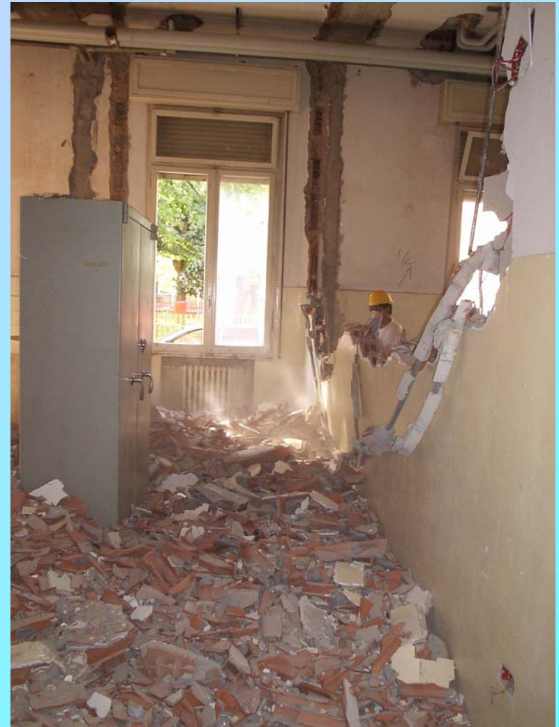
Demolizione manuale muro interno
